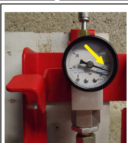
**7** Après ouverture complète des appareils contrôler la pression stabilisée
